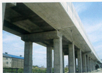
桁下塩害対策
