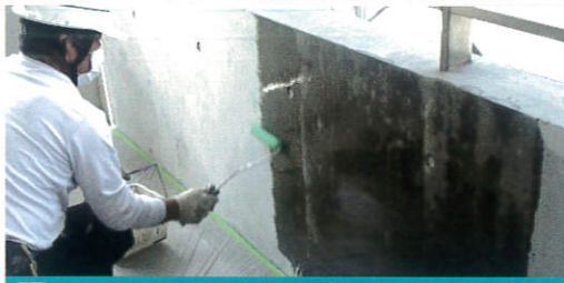
1 REBORNプライマーの塗布
