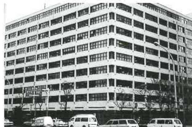
▲写真 1-3 改修後の全景
